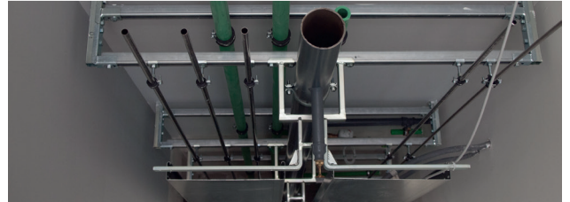
Support combiné ventilation, sprinkler, chimie, sanitaire, électricité, ... Kombinierte Befestigung für Lüftung, Sprinkler, Chemie, Sanitär, Strom, ...
