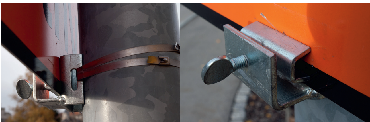
Remplacement de l'adduction d'eau en rigole par des conduites avec brides Omega Ersatz der Wasserzuleitungsrinne durch Rohrleitungen mit Omega-Bride
