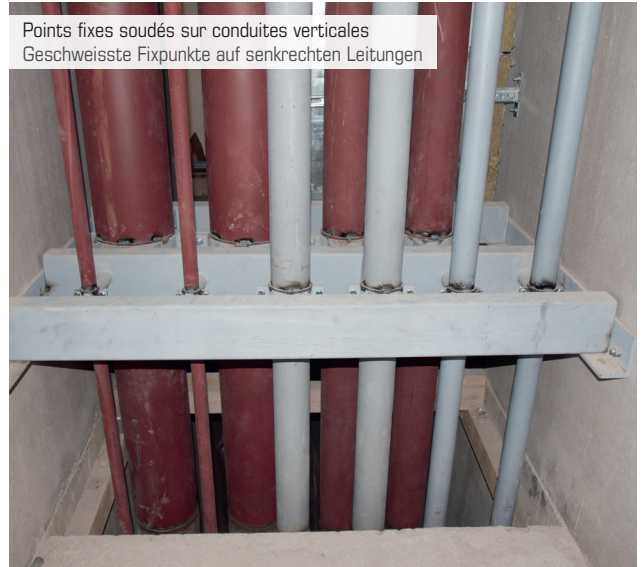
Support combiné ventilation, sprinkler, chimie, sanitaire, électricité, ... Kombinierte Befestigung für Lüftung, Sprinkler, Chemie, Sanitär, Strom, ...
