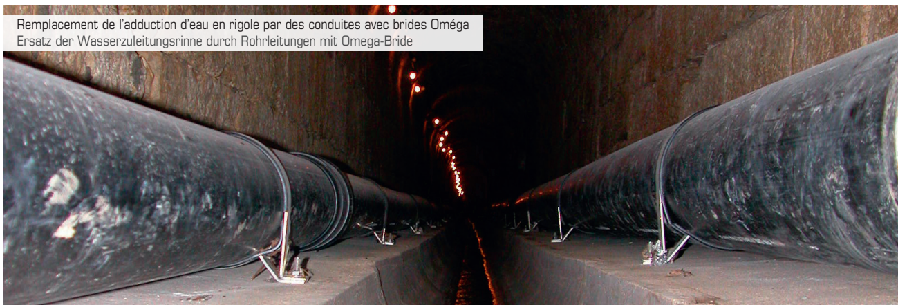
Roulettes sur colliers Rohrschellen auf Rollen
