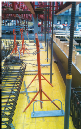
Point fixe triple Dreifacher Fixpunkt
