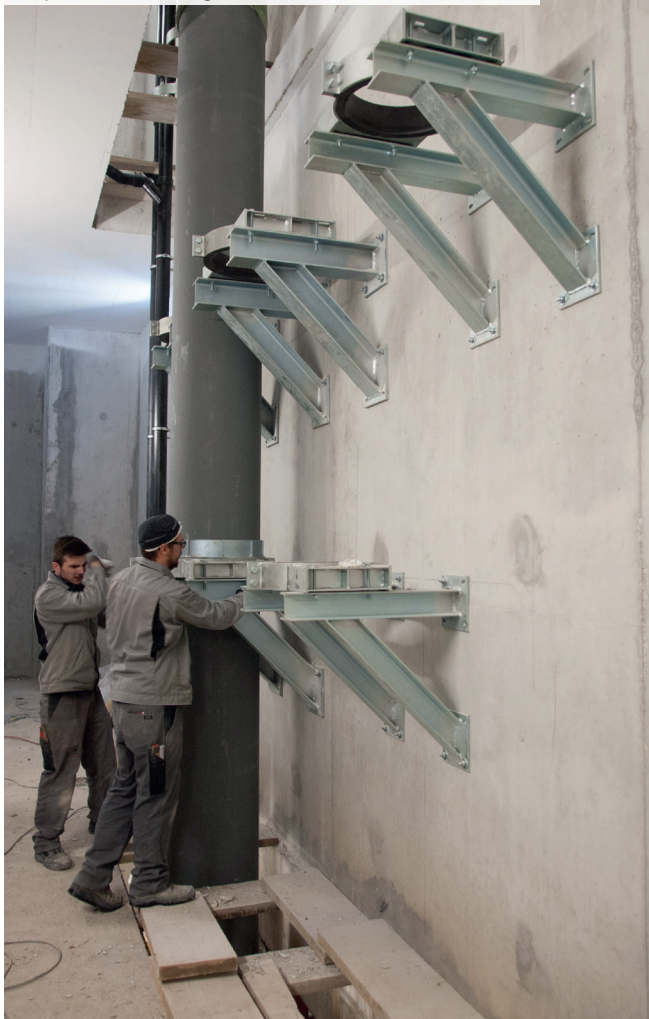
Point fixe froid pour colonne montante dans un centre de calcul Fixpunkt für Kälteleitung in einem Rechenzentrum
