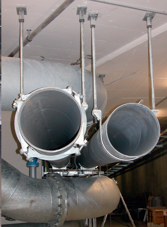
Point fixe pour tuyau double Fixpunkt für Doppelrohr
