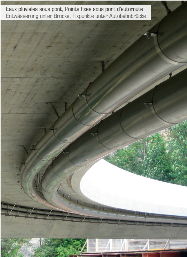
Guidage d'une conduite avec revêtement bitumeux sous un pont Gleiter für Leitung mit Teerbeschichtung unter einer Brücke
