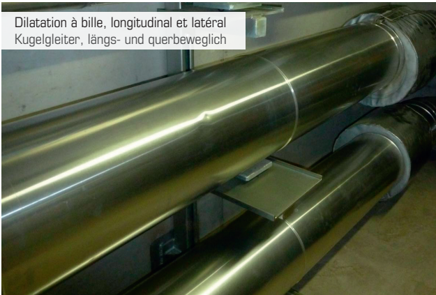
Dilatation à bille, longitudinal Kugelgleiter, längsbeweglich
