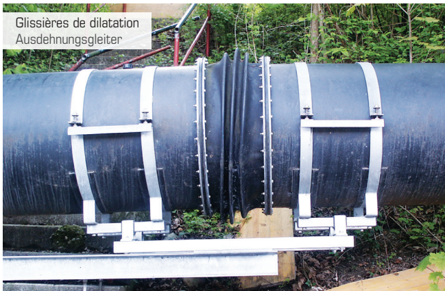
Collier de grand diamètre Rohrschelle mit grossem Durchmesser
