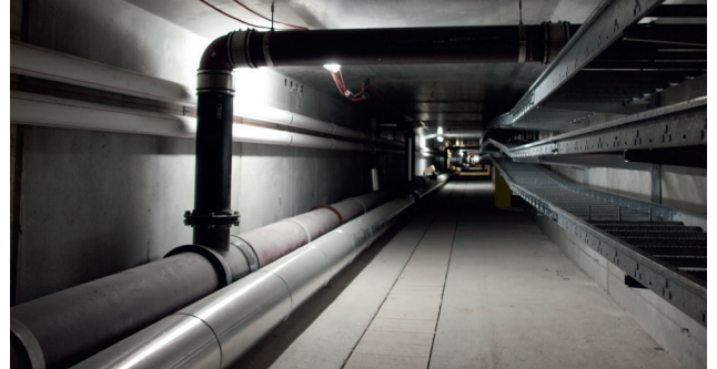
Fixation des conduites d'eau de ruissellement et défense incendie dans un tunnel d'autoroute Befestigung Regenwasser- und Feuerlöschleitung in einem Autobahntunnel
