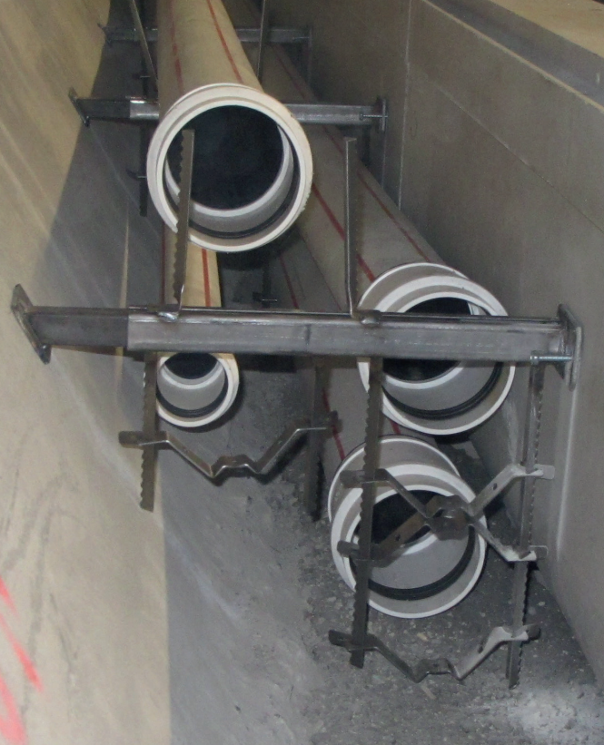
Tubes pour câbles électriques dans un tunnel autoroutier, coulés dans le béton Röhren für Stromkabel in einem Autobahntunnel. Kanal wird mit Beton gefüllt
