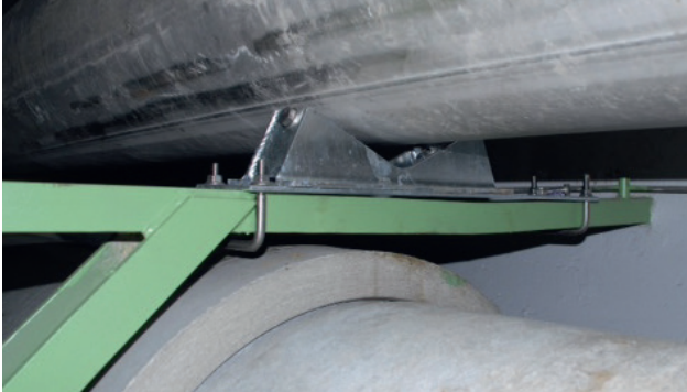
Berceau coulissant pour faciliter la mise en place en milieu étroit Wiege mit Walzen; vereinfacht das Verlegen der Rohre wenn es eng ist
