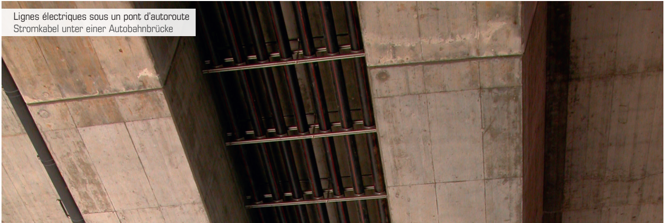
Supportage mixte pour suspension des barres d'alimentation électrique Kombinierte Befestigung zur Aufhängung des Stromschienen
