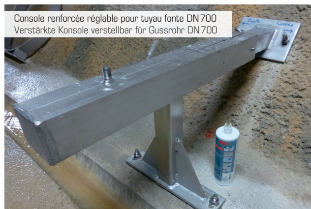
Console en tube carré Konsole aus Vierkanthrohr
