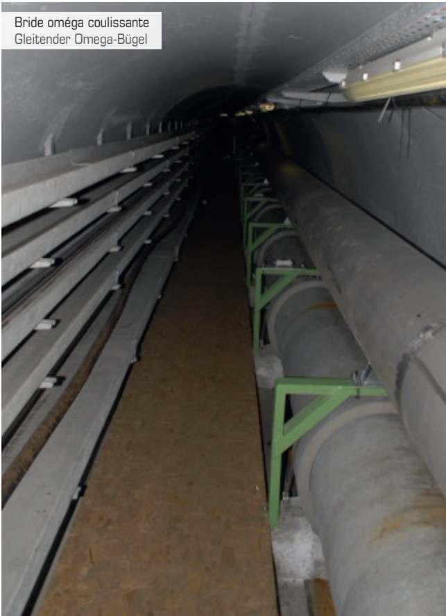
Eaux de ruissellement sous pont d'autoroute Regenwasserleitung unter Autobahnbrücke
