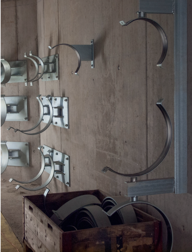
Colliers à 45° et consoles soudées pour faciliter le montage 45°-Rohrschellen und geschweisste Konsolen für vereinfachte Montage
